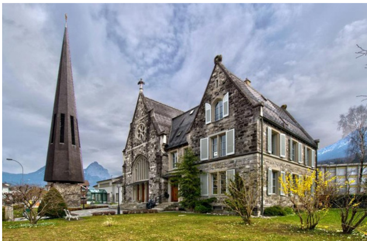
Kirche Brunnen vor dem Umbau 2016
